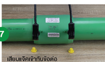
ถอดเสียบจากเครื่องเชื่อม
